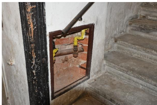
schodiště v 1.NP
