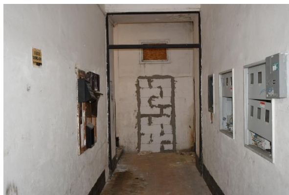
1.NP – vstupní chodba
